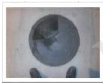
12. マンホールの上にアウトリガーを設置すると割れます
