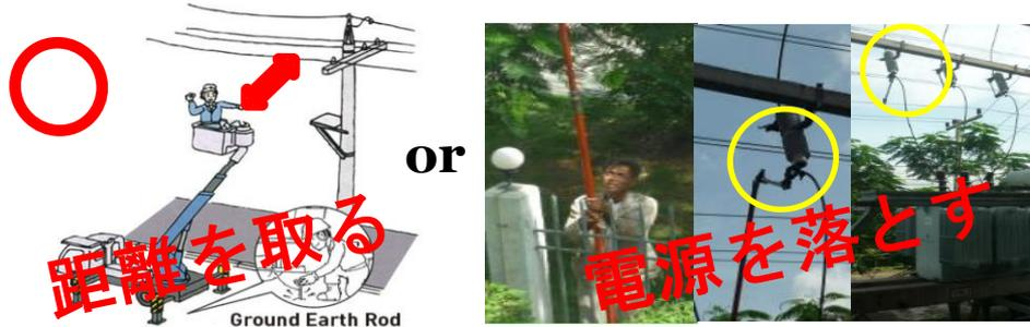
② そのためFRPバケットを用いても、直接電線に接触できるわけではありません。十分な距離を保つか、完璧に電源をおとして作業してください。
